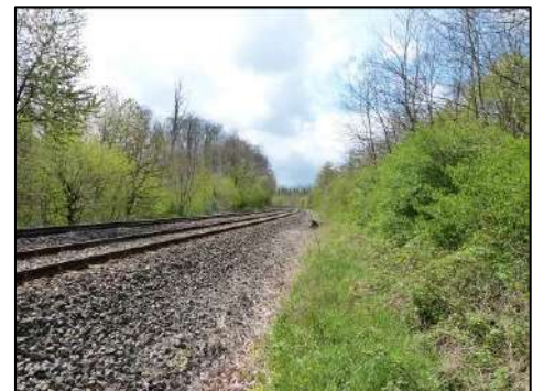
Figure 42: La voie ferrée en limite Est du périmètre du projet
