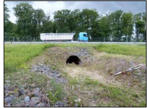
Figure 43 : La buse hydraulique traversant l'autoroute à proximité de la zone d'étude
