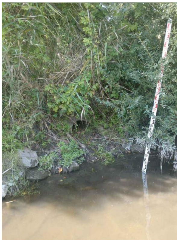
Situation de la connexion entre le Rottgraben et l'Andlau : busage obstrué et berge enrochée
