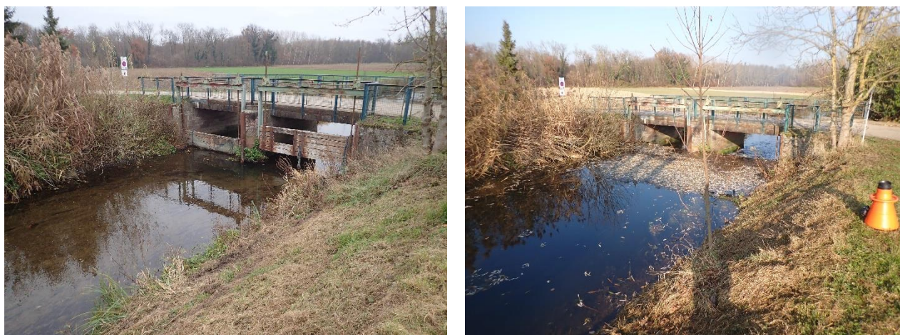
Figure 7 : Ouvrage ROE 23 897 en octobre 2021 (à gauche) et en novembre 2021 (à droite)
