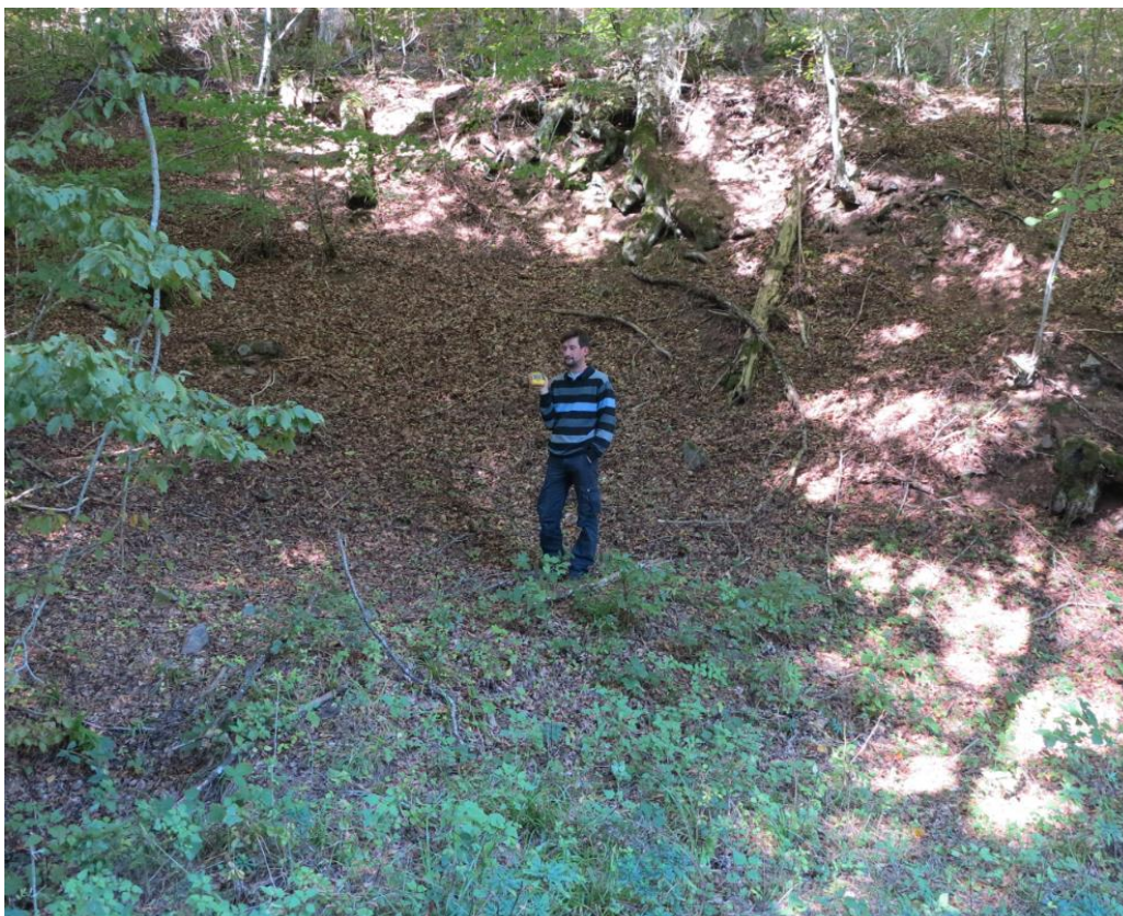
Photo 67 : Galerie du troisième niveau G36 éboulée en tête
