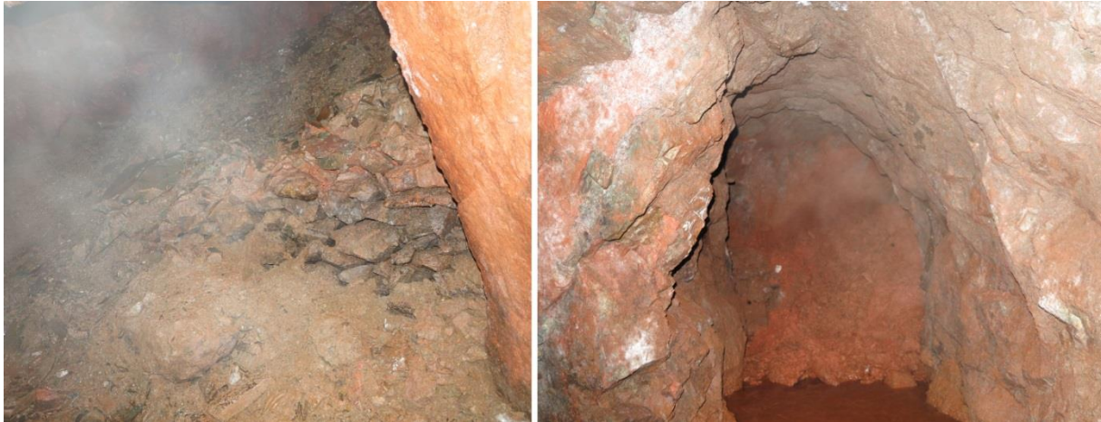
Photo 4 : Désordre D1 de type fontis pris en photographie depuis le fond
