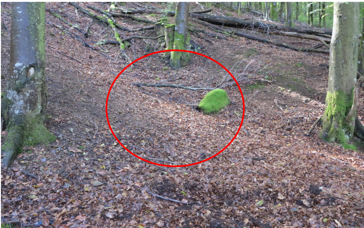
Photo 60 : Galerie G31 éboulée en tête
