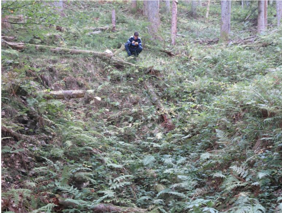
Photo 53 : Galerie G28 éboulée en tête
