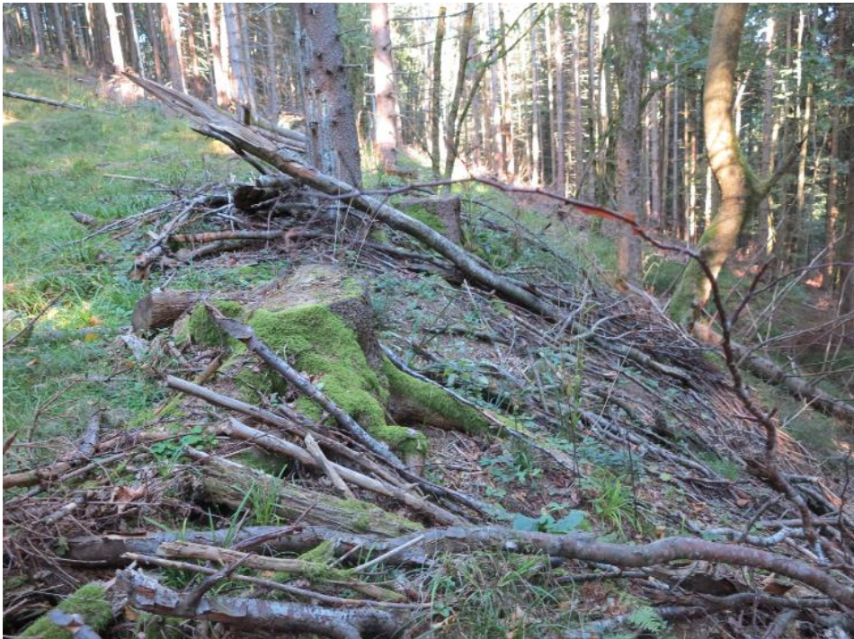
Photo 38 : Ouvrage de dépôt T22 associé à la galerie G21 éboulée en tête
