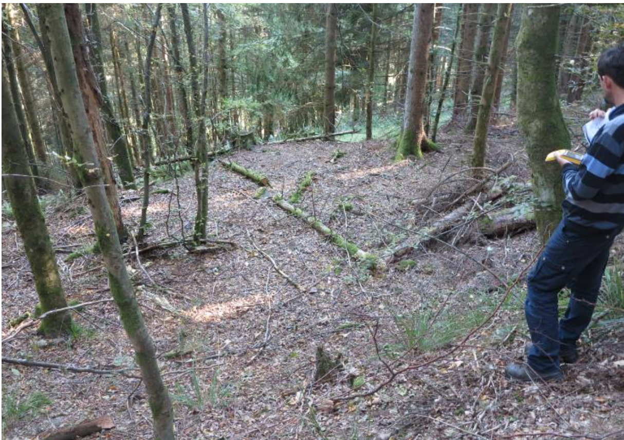
Photo 44 : Galerie G23 éboulée en tête et ouvrage de dépôt T24 associé en contrebas
