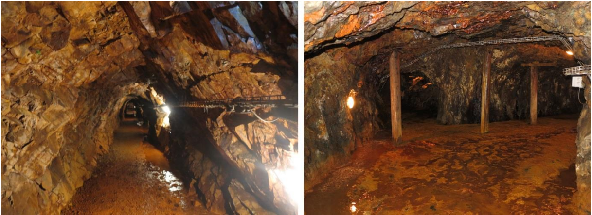
Photo 2 : Corps de la galerie G1
