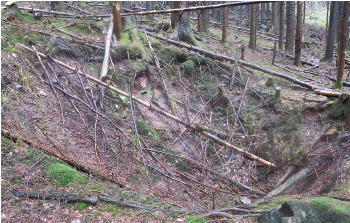
Photo 10 : Désordre D2 au niveau de la galerie supérieure de la Mine Grise G6
