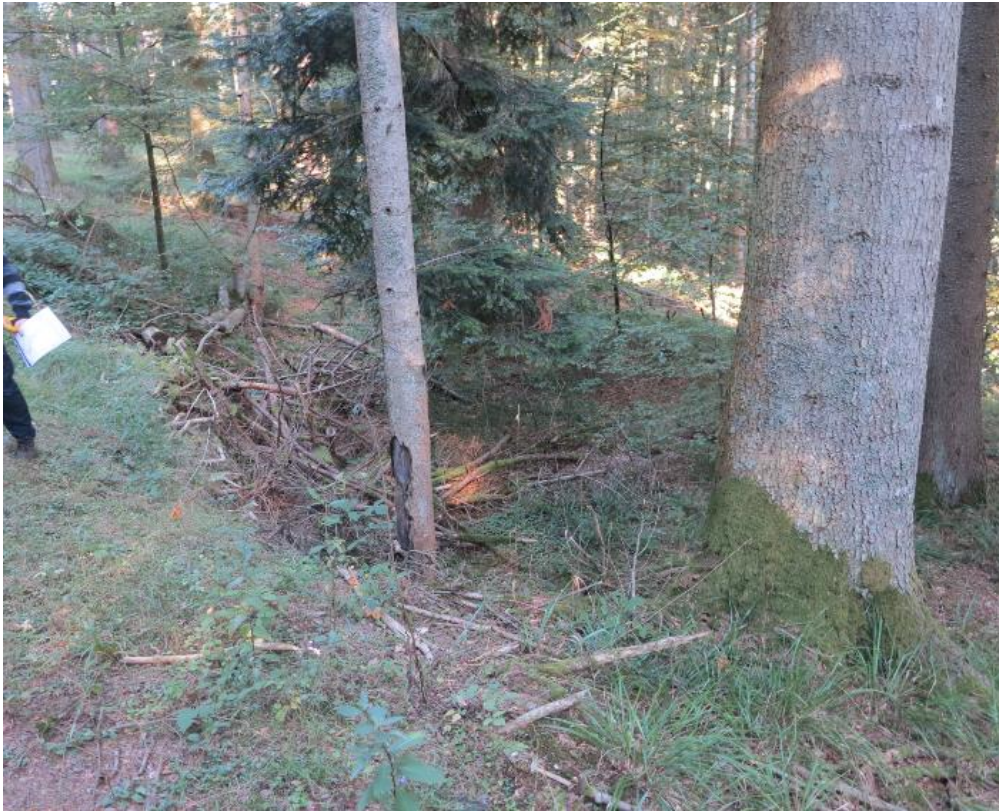
Photo 45 : Galerie G24 éboulée en tête et ouvrage de dépôt T25 associé en contrebas
