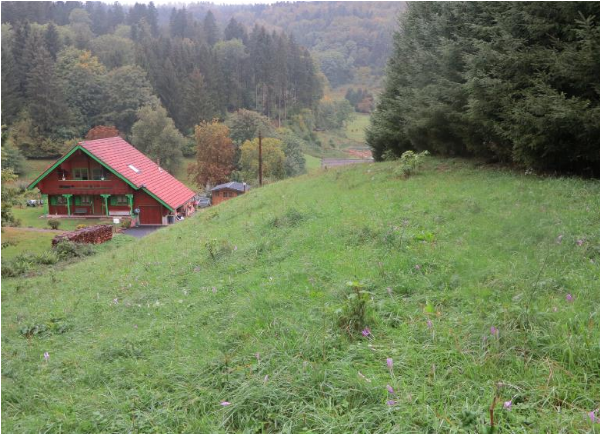
Photo 17 : Ouvrage de dépôt T1 associé à la galerie inférieure de la Mine Noire G7 (vue prise du haut)
