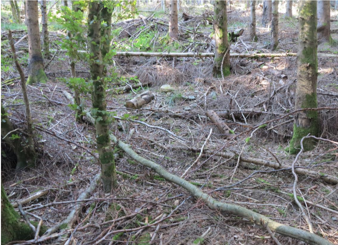
Photo 33 : Galerie G19 éboulée en tête
