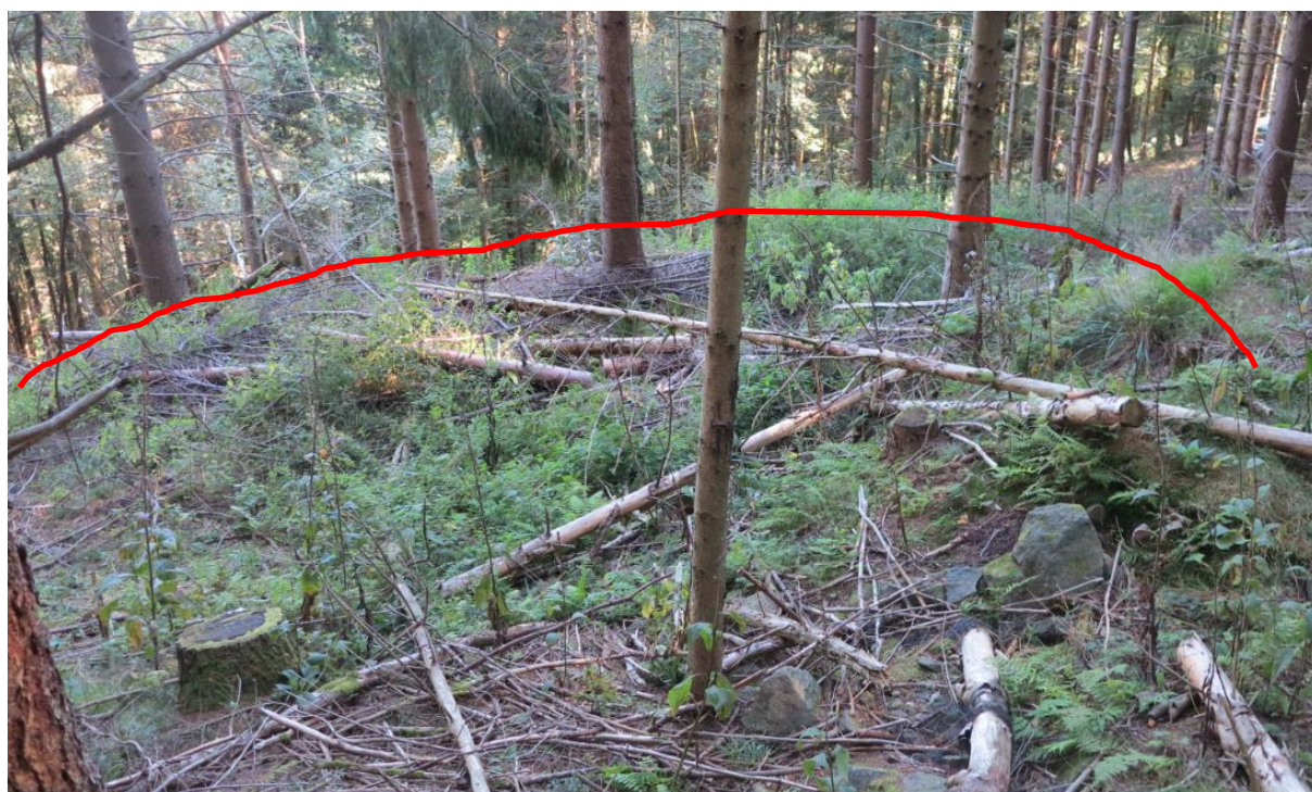
Photo 30 : Ouvrage de dépôt T18 associé à la galerie G17 éboulée en tête
