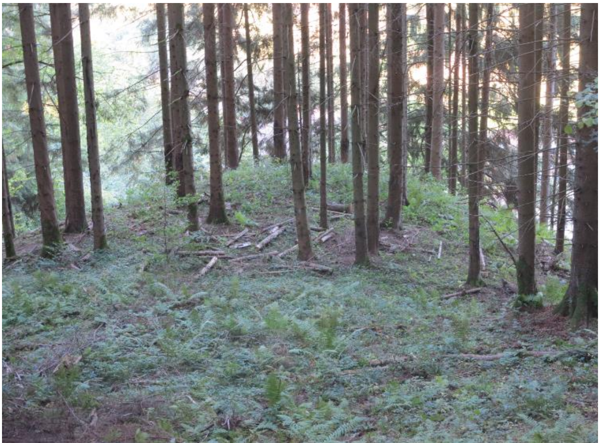
Photo 54 : Ouvrage de dépôt T29 associé à la galerie G28 (vue amont)
