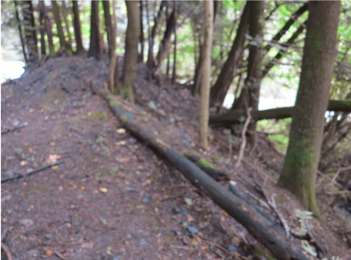
Photo 59 : Ouvrage de dépôt T32 associé à la galerie G30
