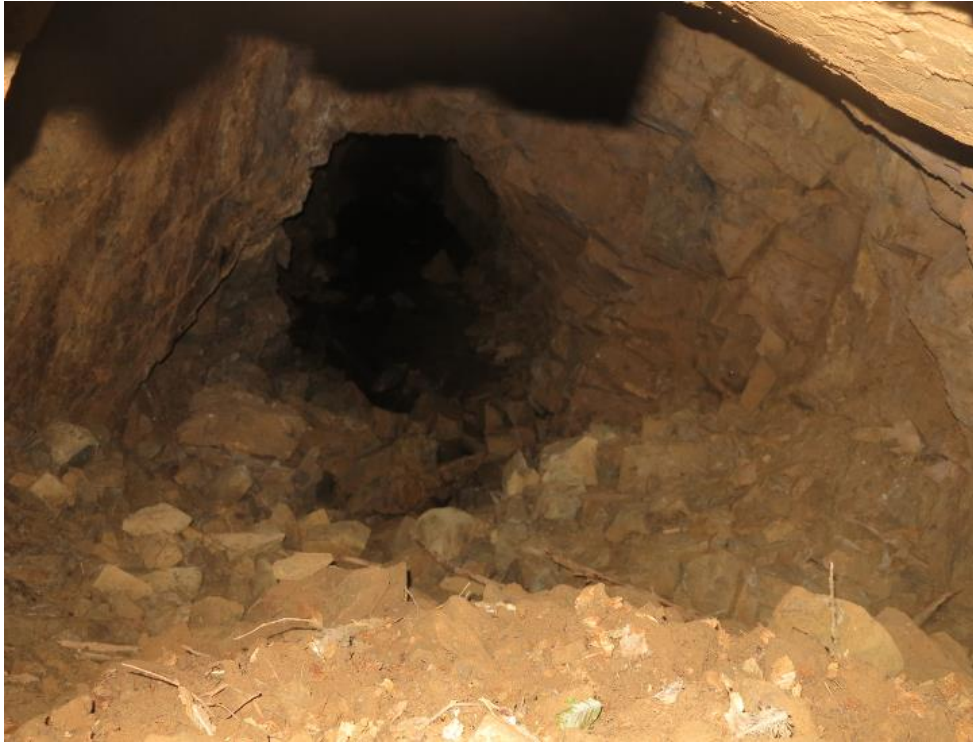
Photo 51 : Corps de la galerie semi-ouverte G27
