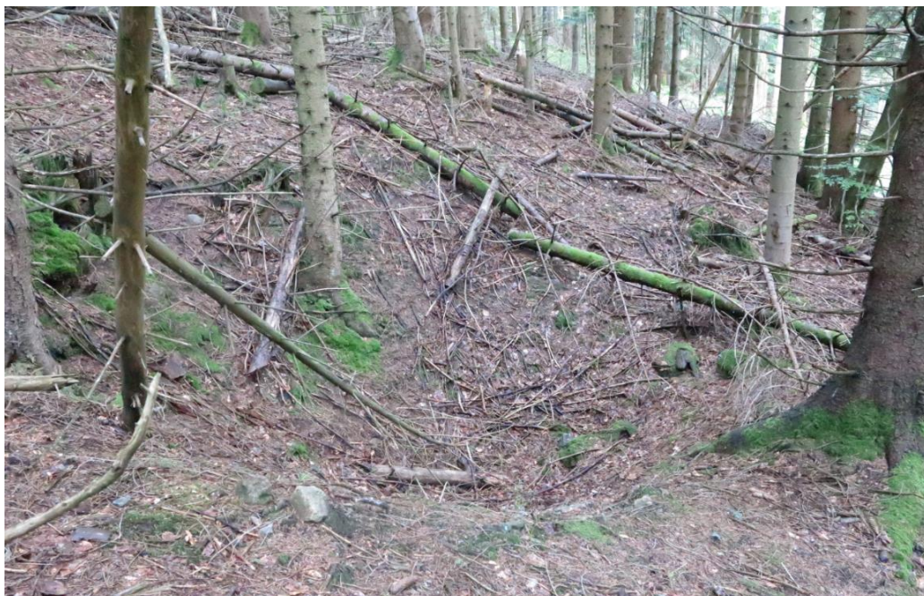
Photo 14 : Désordre D3 de type fontis au droit de la galerie inférieure de la Mine Noire G7
