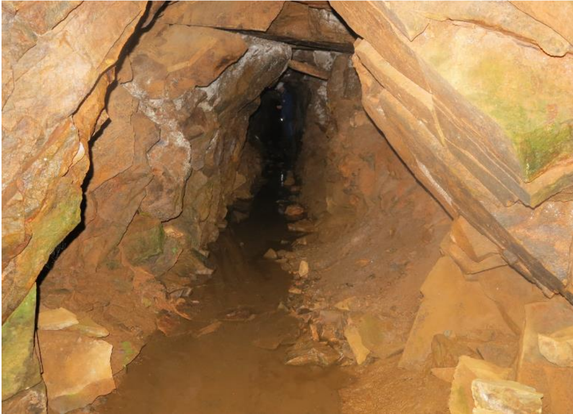
Photo 24 : Corps du travers-banc d'écoulement G11 de la Mine Jaune
