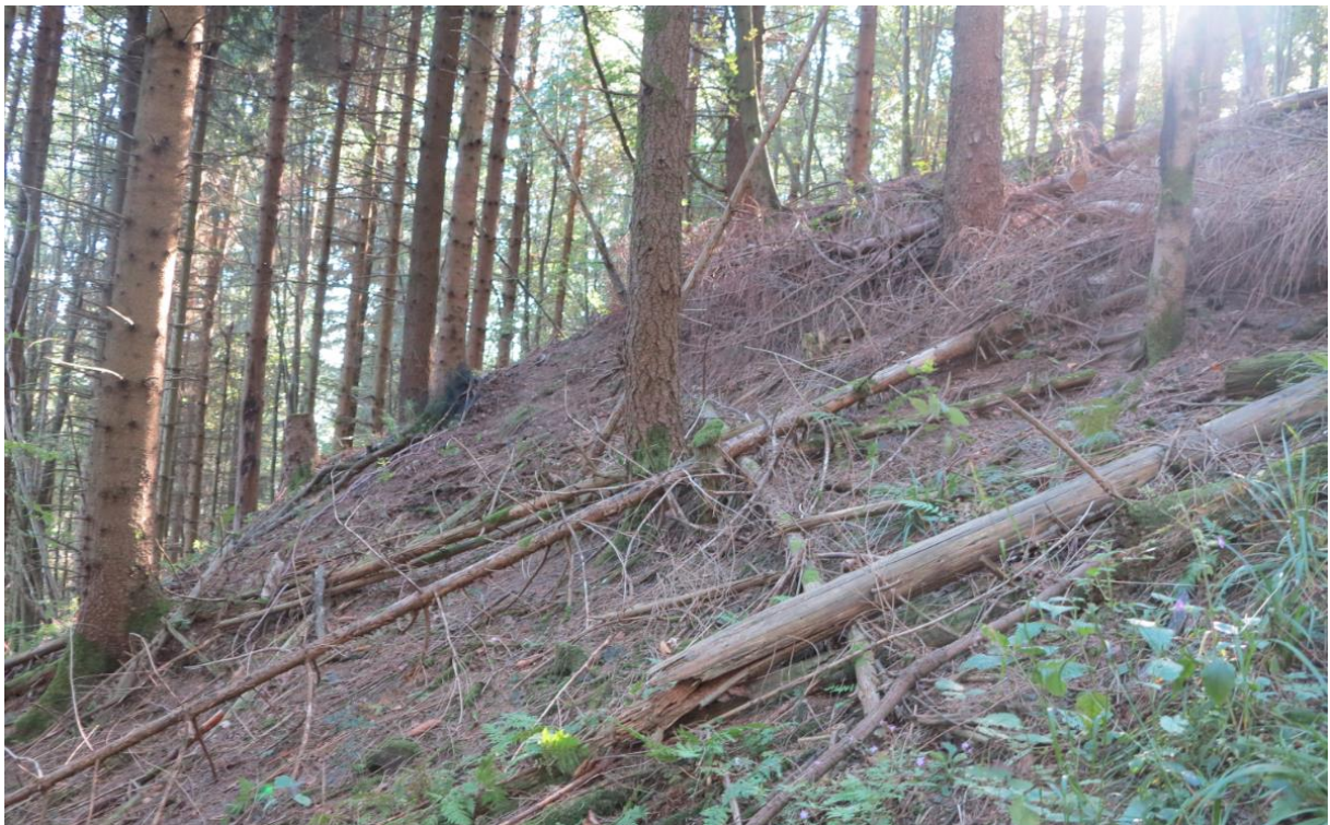
Photo 34 : Ouvrage de dépôt T20 associé à la galerie G19 éboulée en tête
