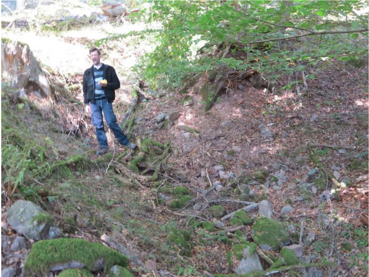
Photo 75 : Désordre D11 de type fontis à l'aplomb de travaux souterrains
