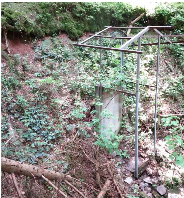
Photo 9 : Galerie supérieure de la Mine Grise G6 murée en tête
