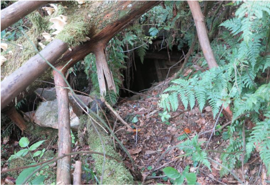
Photo 20 : Travers-banc de la Mine des Engins G10 boisé en tête
