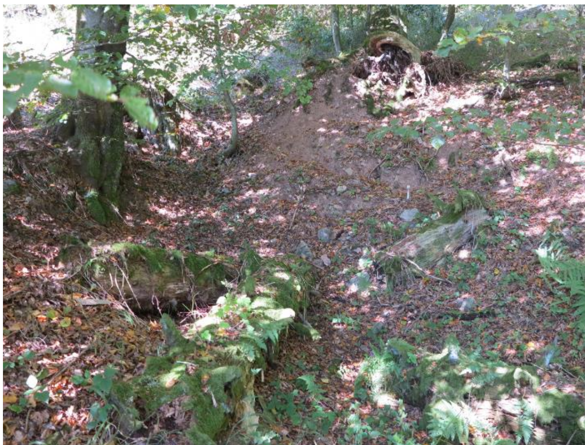
Photo 70 : Galerie du deuxième niveau G37 éboulée en tête
