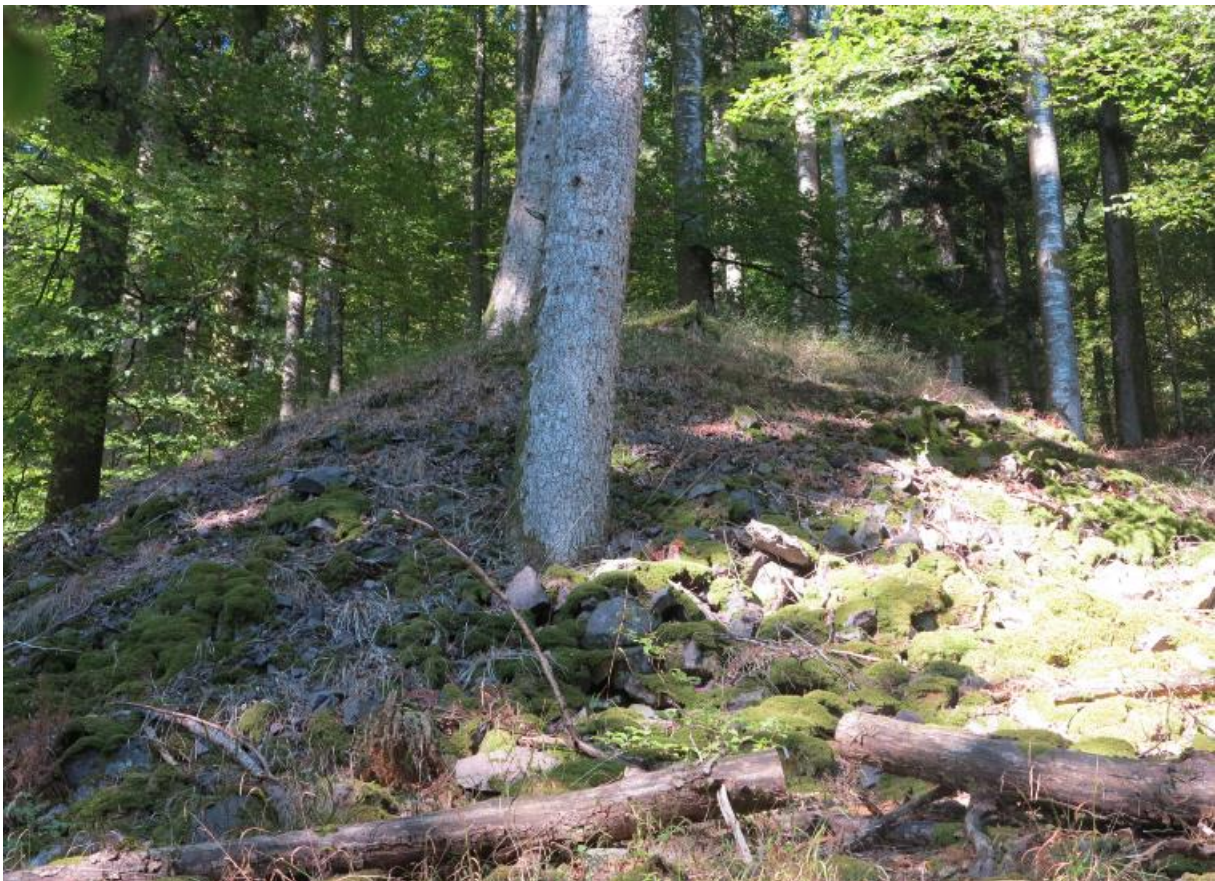
Photo 74 : Ouvrage de dépôt T39 associé à la galerie du premier niveau G38
