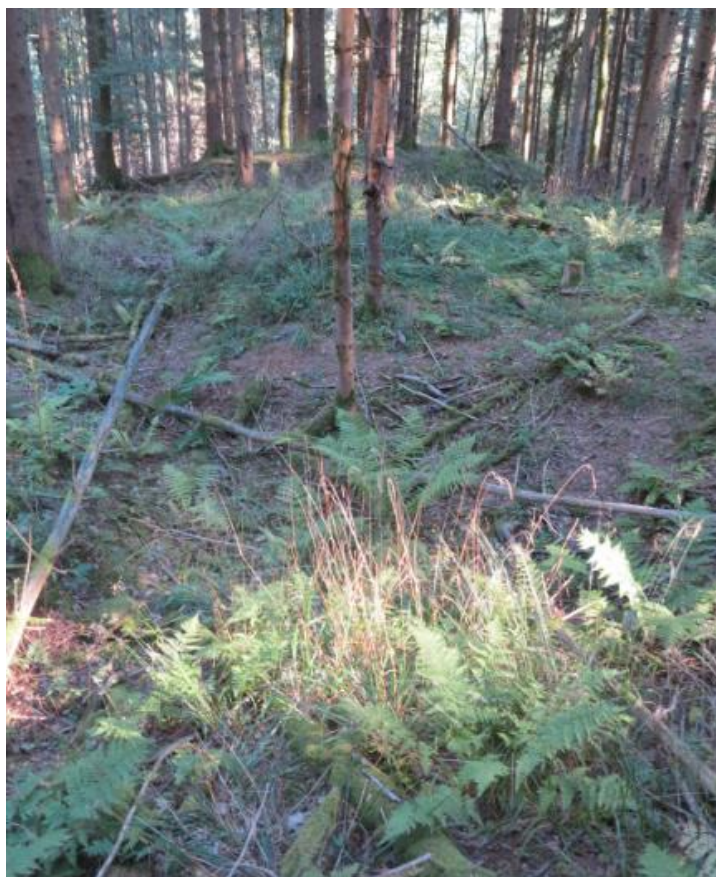
Photo 39 : Galerie G22 éboulée en tête et ouvrage de dépôt T23 associé en contrebas
