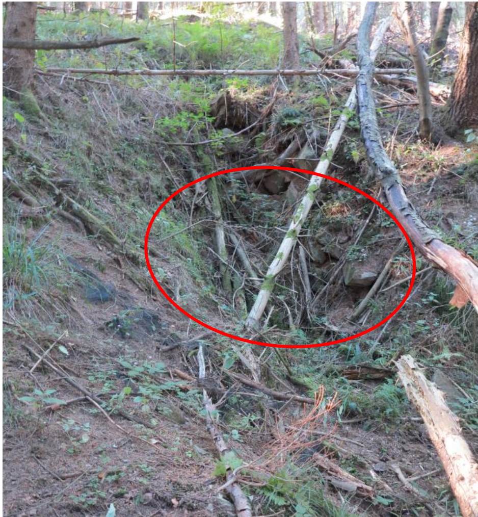
Photo 31 : Galerie G18 éboulée en tête
