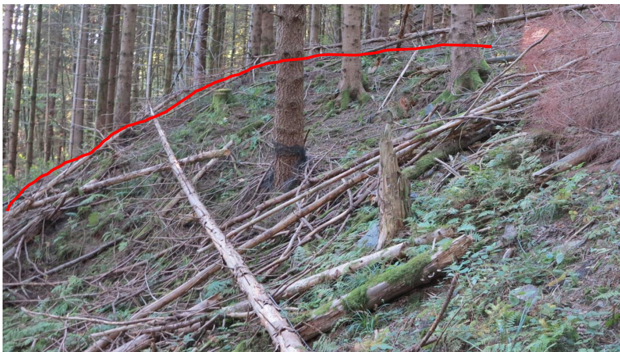
Photo 32 : Ouvrage de dépôt T19 associé à la galerie G18 éboulée en tête
