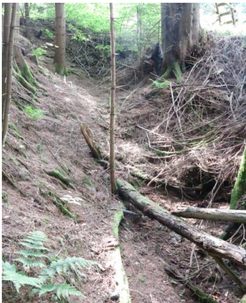
Photo 26 : Galerie « Recherche du Curé » éboulée en tête G15
