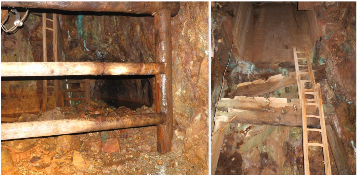
Photo 3 : Photographie de l'intérieur du puits de l'Engin
