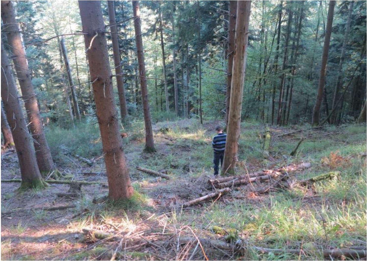
Photo 47 : Galerie G25 éboulée en tête et ouvrage de dépôt T26 associé en contrebas
