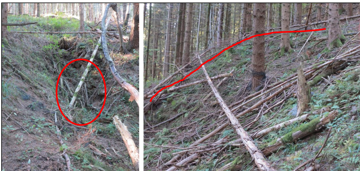
Figure 22 : Galerie de recherche G18 éboulée en tête et son ouvrage de dépôt T19 (clichés GEODERIS, 30/09/2015)
