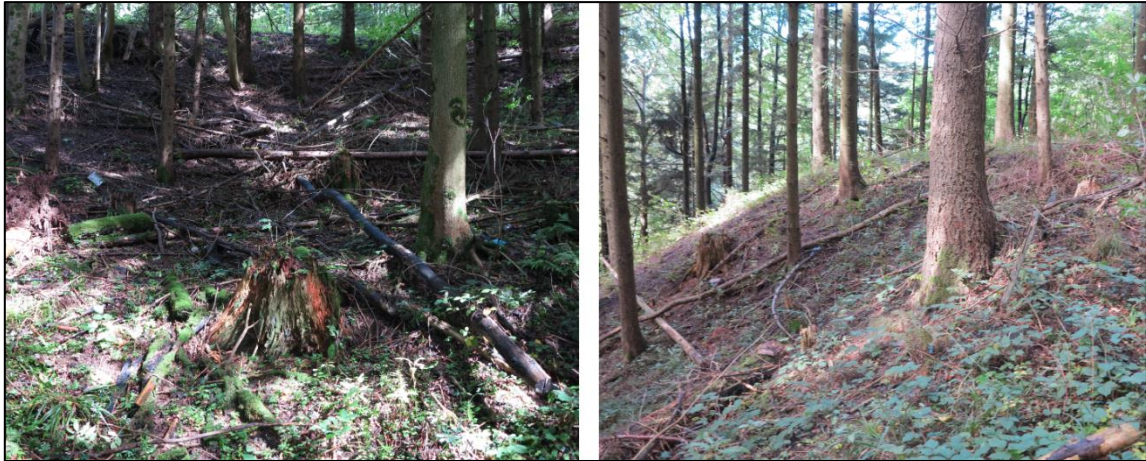
Figure 32 : Galerie de recherche G29 éboulée en tête et son ouvrage de dépôt T31 (clichés GEODERIS, 16/09/2015)
