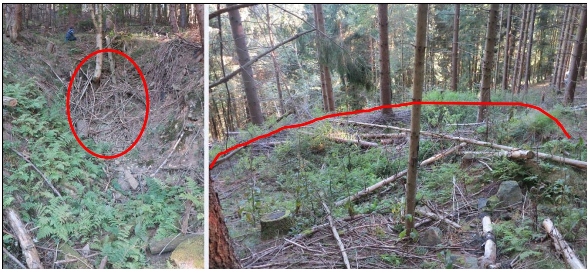
Figure 21 : Galerie de recherche G17 éboulée en tête et son ouvrage de dépôt T18 (clichés GEODERIS, 30/09/2015)
