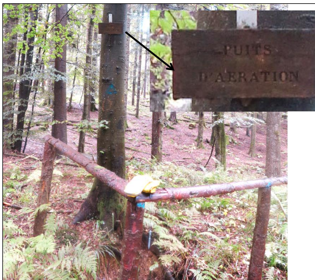
Figure 15 : Photographie du puits d'aération situé à proximité de la Mine des Engins (cliché GEODERIS, 30/09/2015)
