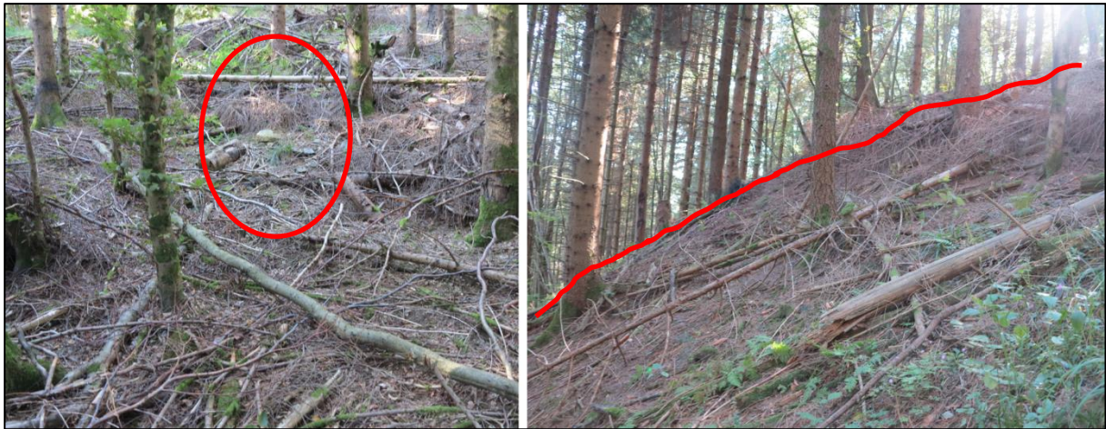
Figure 23 : Galerie de recherche G19 éboulée en tête et son ouvrage de dépôt T20 (clichés GEODERIS, 30/09/2015)
