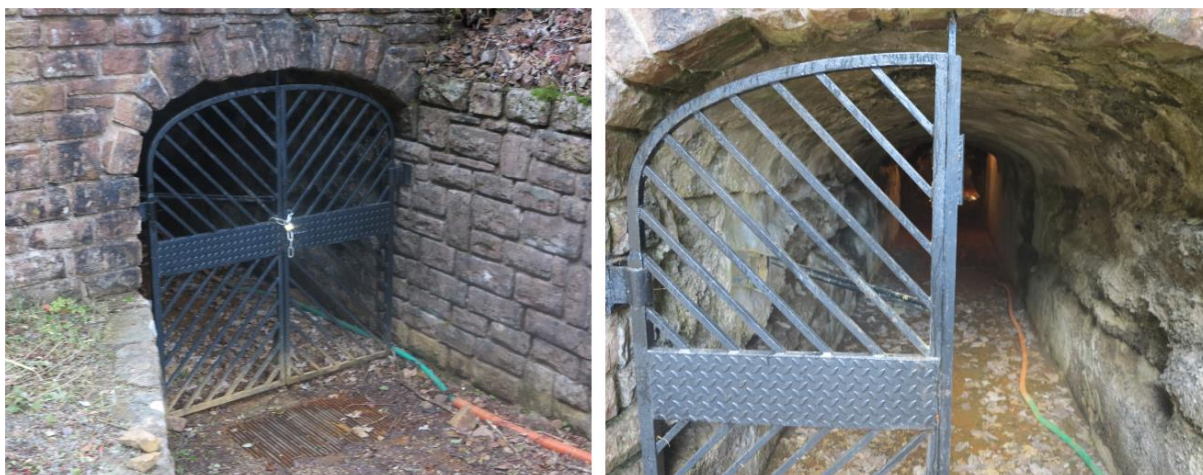
Figure 6 : Photographies de l'entrée de la galerie des Minières G1 (clichés GEODERIS, 19/09/2015)
