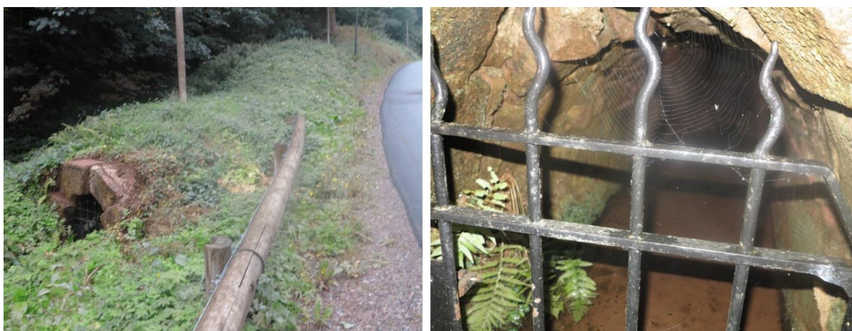
Figure 7 : Photographies de l'entrée de l'ancienne galerie des Minières G2 (clichés GEODERIS, 29/09/2015)
