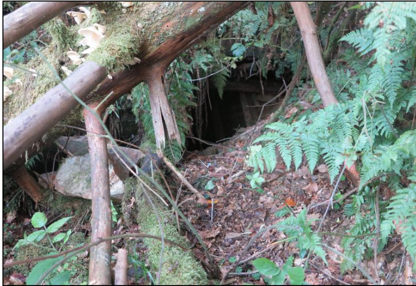
Figure 12 : Photographie de l'entrée du travers-banc de la Mine des Engins G10 (cliché GEODERIS, 30/09/2015)
