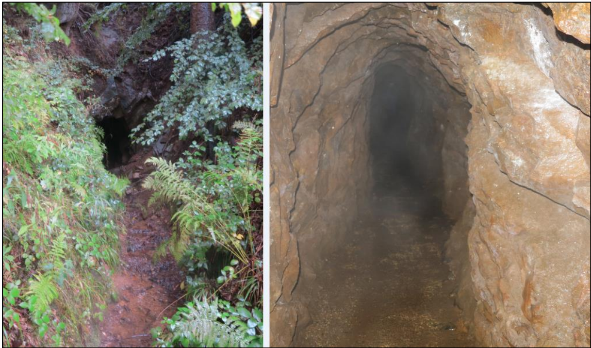
Figure 18 : Photographies du travers-banc d'écoulement de la Mine Jaune G11 (clichés GEODERIS, 30/09/2015)
