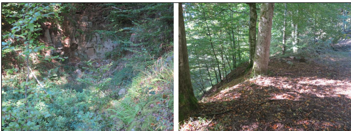
Figure 37 : Galerie supérieure de l'Evêché G34 éboulée en tête et son ouvrage de dépôt T35 (clichés GEODERIS, 29/09/2015)
