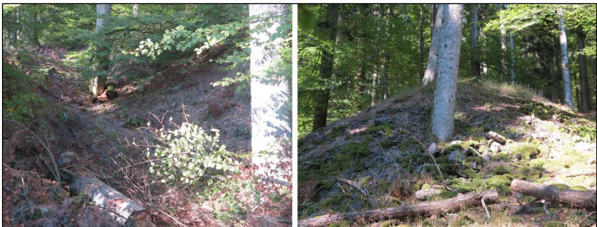
Figure 42 : Galerie du premier niveau G38 et son ouvrage de dépôt T39 (clichés GEODERIS, 30/09/2015)
