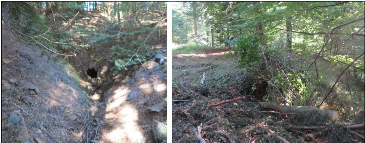
Figure 36 : Galerie inférieure de l'Evêché G33 ouverte et son ouvrage de dépôt T34 (clichés GEODERIS, 29/09/2015)
