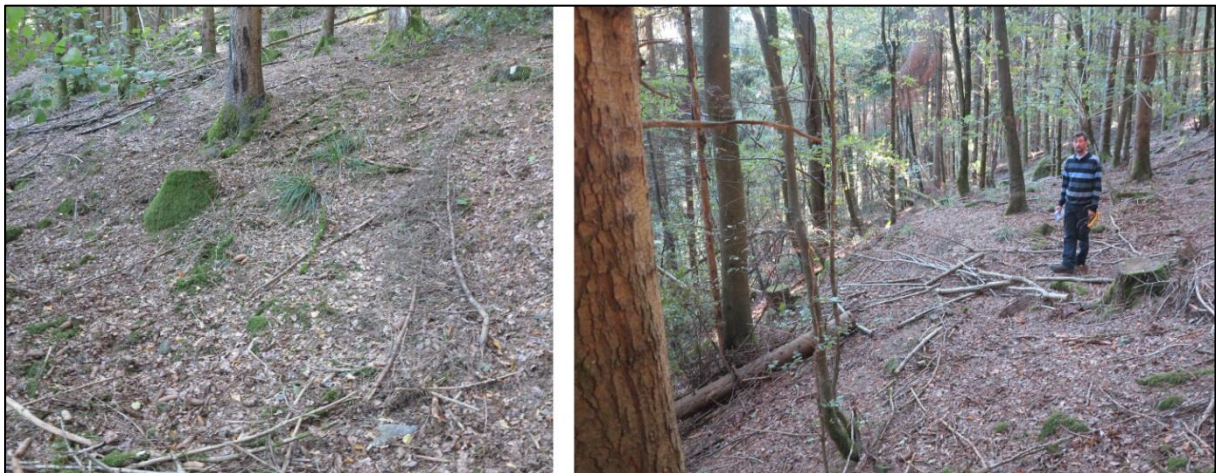
Figure 24 : Galerie de recherche G20 éboulée en tête et son ouvrage de dépôt T21 (clichés GEODERIS, 30/09/2015)
