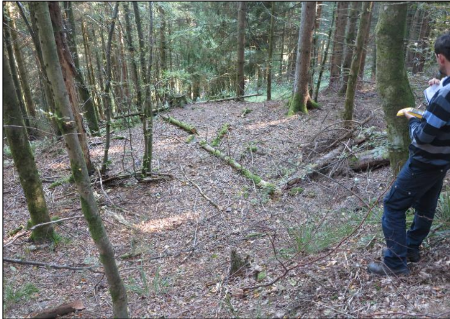
Figure 27 : Galerie de recherche G23 éboulée en tête et son ouvrage de dépôt T24 (cliché GEODERIS, 30/09/2015)
