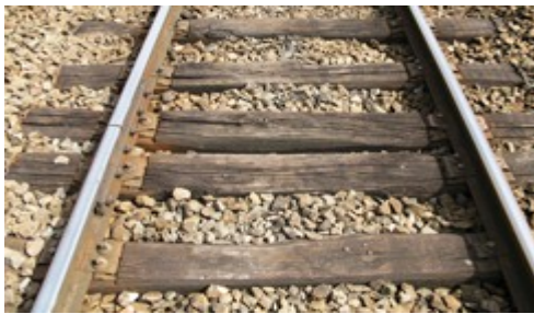
Rails courts sur traverses bois
