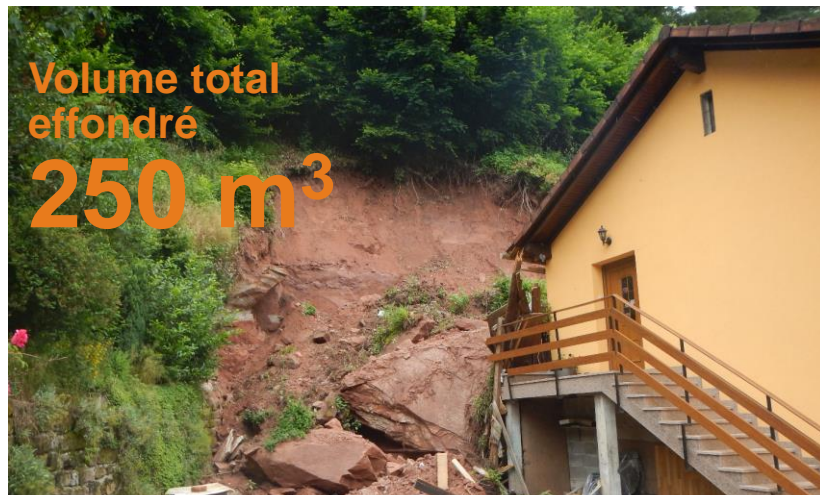
Eboulement de juin 2016 au 14, rue du Vieux Moulin
