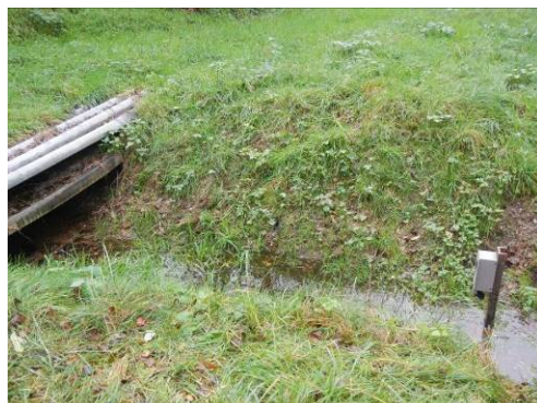
Piège photographique au niveau de la buse hydraulique pr 470.1
