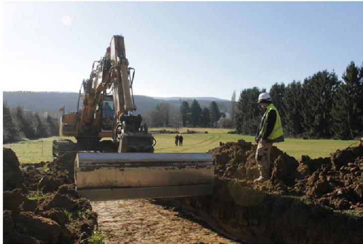
*Pelle mécanique réalisant une fenêtre dans le cadre d'un diagnostic archéologique*
