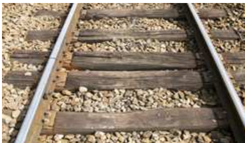
Rails courts sur traverses bois
